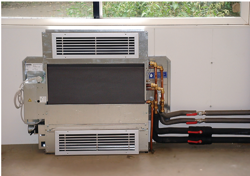
Ventilatorconvector (inbouwmodel DECO) met aanzuig- en uitblaasroosters
